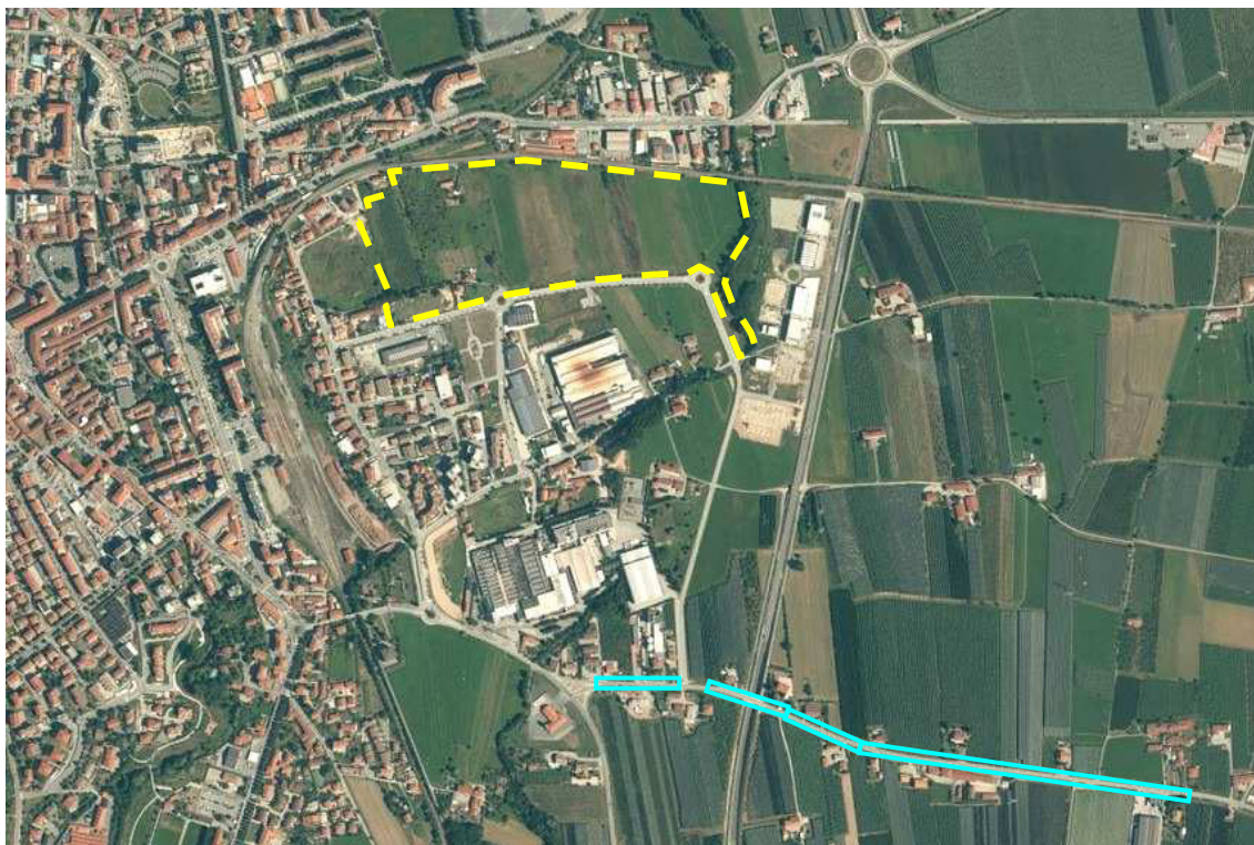
Vista aerea delle zone di intervento sulla viabilità esterna
