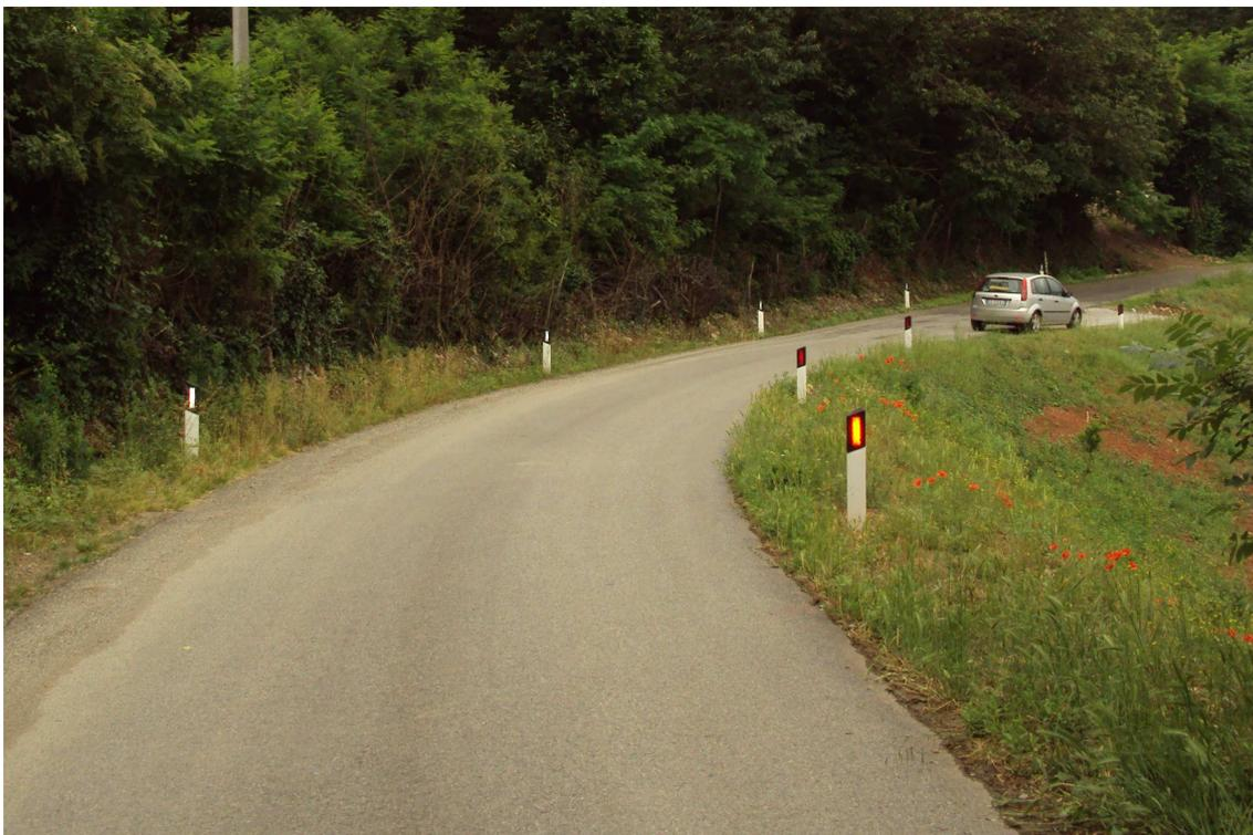
Foto 6\_Nel immagine si osserva la pendenza della scarpata e la dimensione limitata del ciglio stradale
