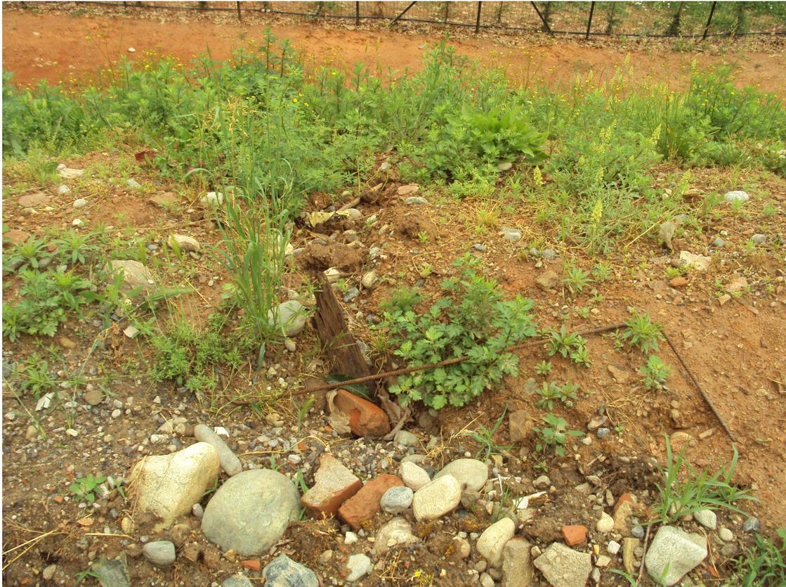
Foto 5\_Tratto di scarpata dove in seguito a piogge violente si è verificato uno smottamento del terreno
