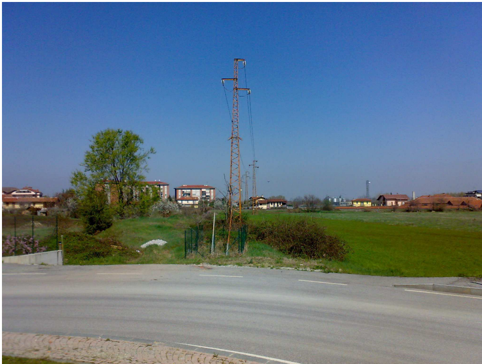
Vista dalla rotatoria di Via Lattanzi / Via Gatti verso la linea ferroviaria
