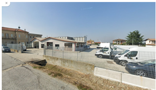
3- Vista viabilità interna esistente a Sud-Ovest
