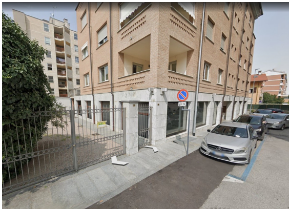
1-Vista su via Isasca
