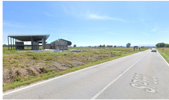
4- vista verso sud dalla zona industriale
