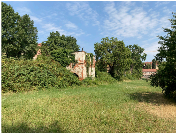
L'antico edificio medievale
